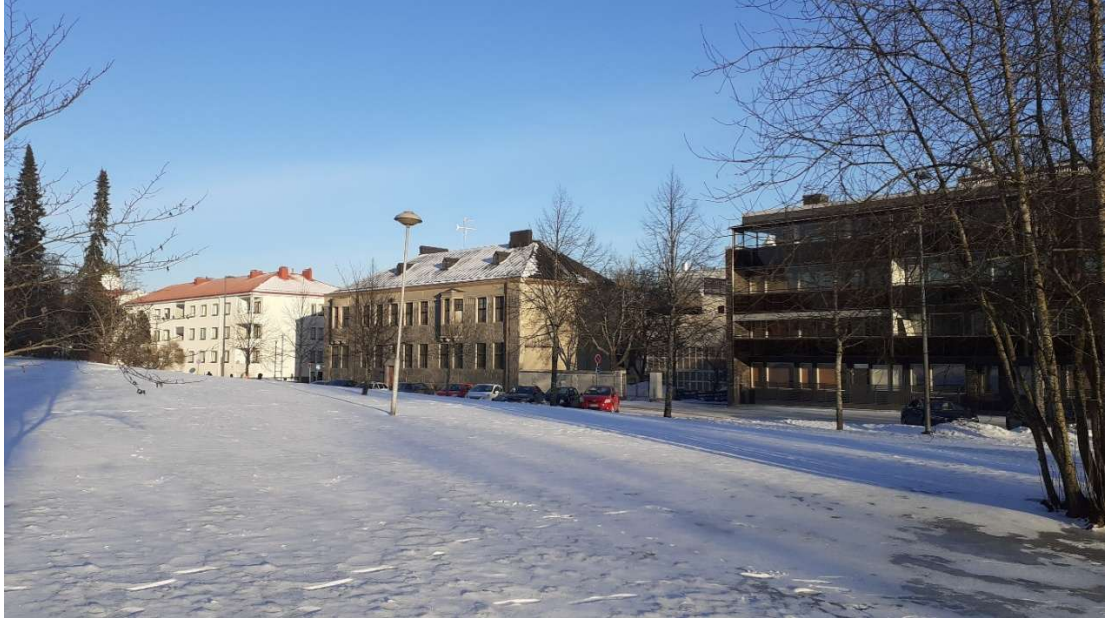
Kuva 2. Ristimäenpuisto ja Ristimäenkatu. Keskellä Graniittitalo.
